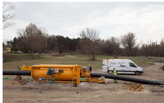
Csővona- t áthú- zása reduk- ciós egysé- gen
