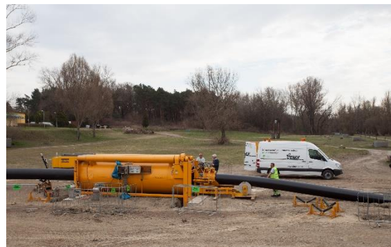
Csővona- t áthúzása redukációs egységen
