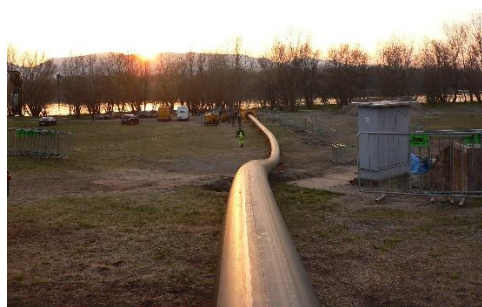
Folyó alatti csőátvezetés
