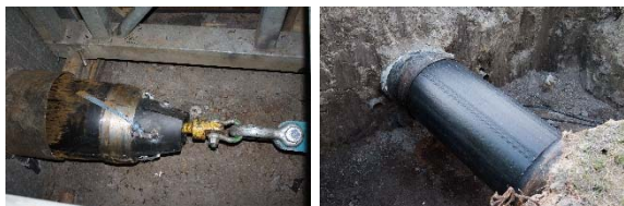
Behúzófej érkezése a fogadó aknához
