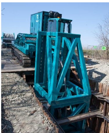
Csőrlőállás a fogadóaknáknál
