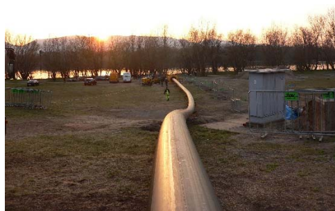
Folyó alatti csőátvezetés
