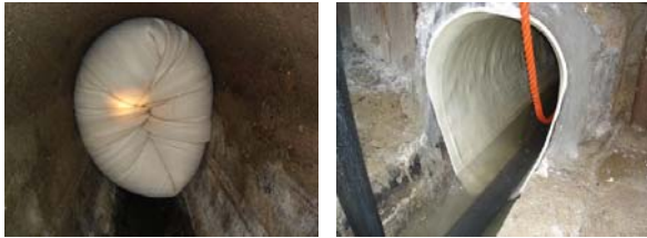
A tömlő befordulása, kikeményítése
